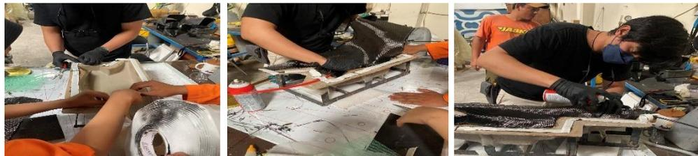
**Gambar 9. Persiapan Cetakan dan Pemasangan serat**
