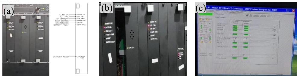
Gambar 7. (a) Indikator normal pada BCPS, (b)(c) Parameter saat On Battery Mode
