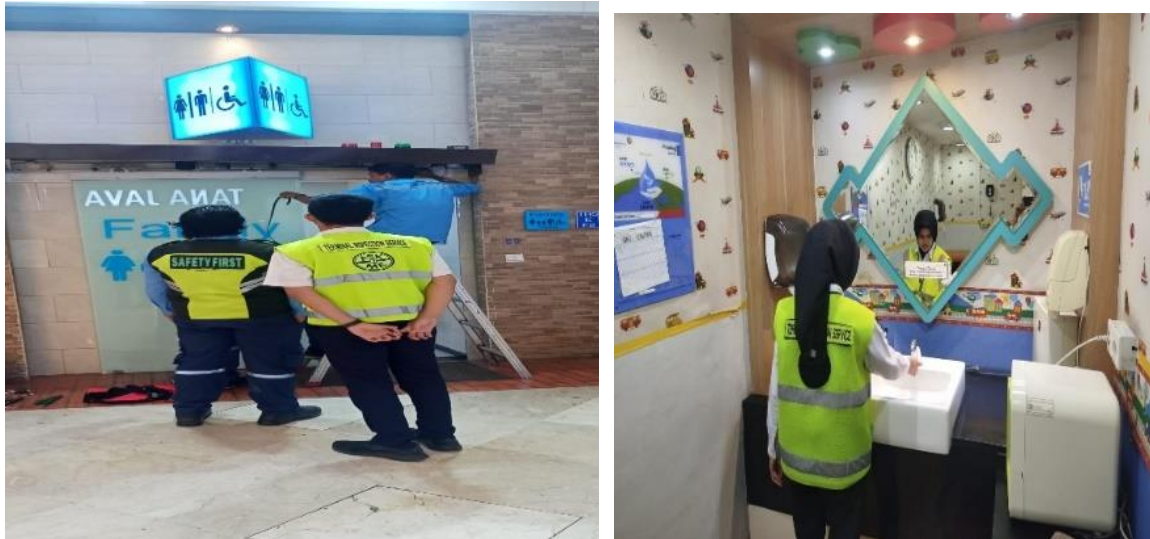
Gambar 5. Kerusakan pada sensor pintu dan air di nursery
