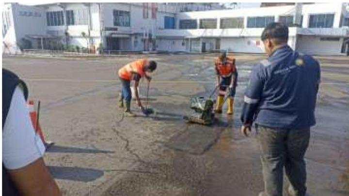
**Gambar 2 Perbaikan Weakspot**
