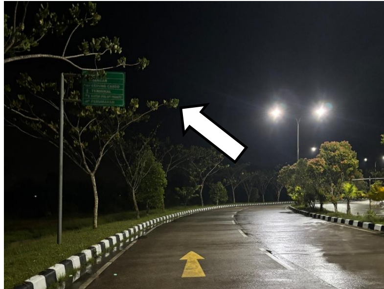
Gambar 1. Rambu petunjuk arah dengan material yang belum sesuai (Sumber : Dokumentasi Penulis)
