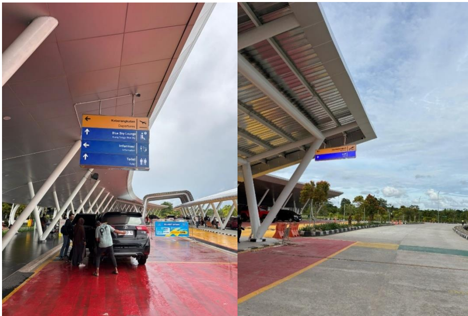
Gambar 13. Penambahan signboard di terminal keberangkatan dan kedatangan penumpang (Sumber : Dokumentasi Penulis)
